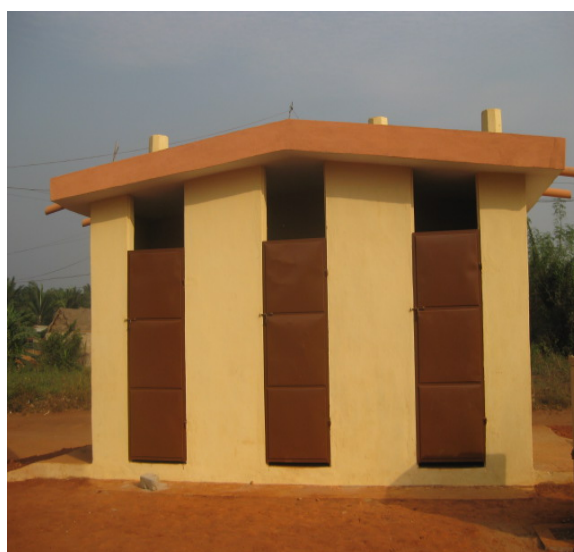
Bloc de latrines VIP double fosse
