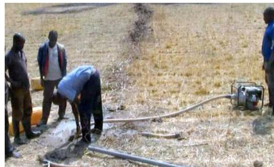
Forage avec le tube alu et la motopompe et pose du tuyau PVC (Ouessè)
