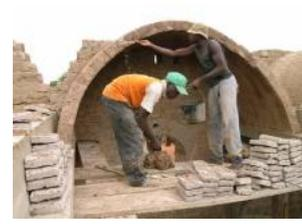
Construction de la voûte à l'aide d'une corde et de briquettes de 4 cm d'épaisseur
