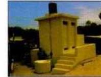
Modèle de latrine sur fosse septique (séparation parties solides/liquides), avec système de chasses d'eau constituée d'une pompe à main (© Areed)
