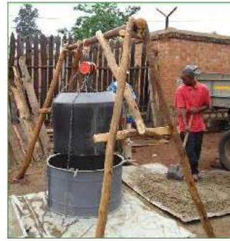
Fabrication d'une buse
