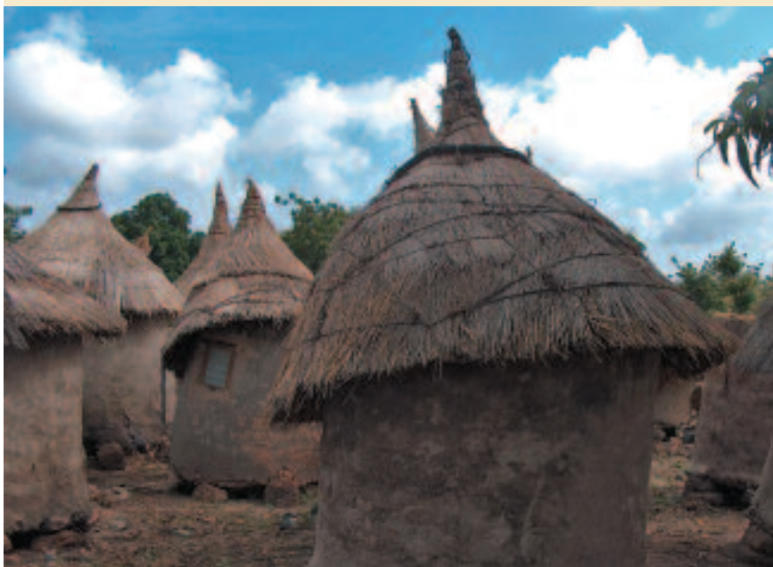
Photo 4. Chaume de greniers tressé avec de l'écorce de Piliostigma reticulatum . Photo B. Yelemou.
